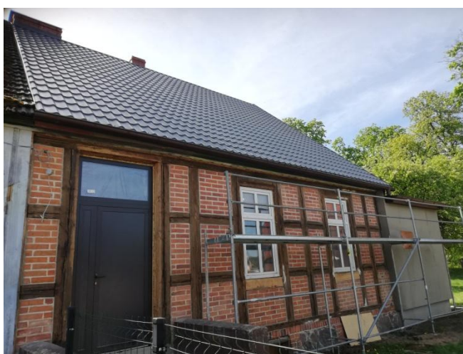
Świetlica w remoncie
